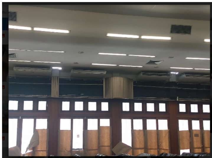
Foto 3: Instalação das evaporadoras dos ar-condicionados tipo Split do Salão Nobre
