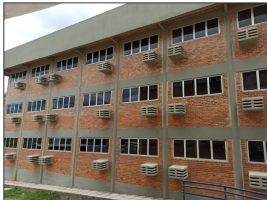
Foto 2: Fachada lateral do prédio de professores.
