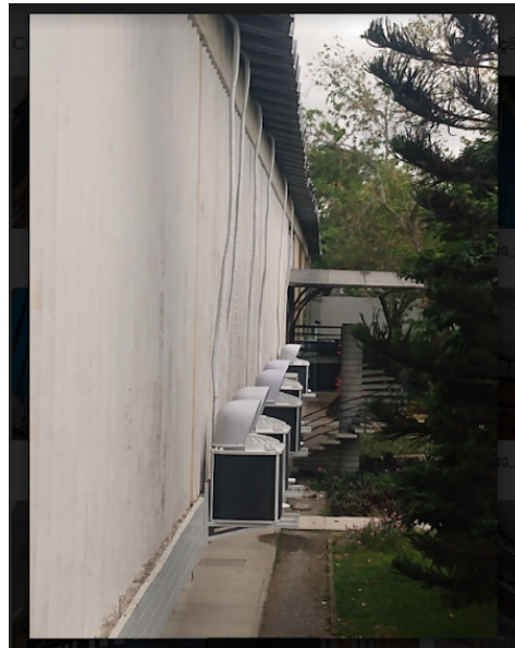
Foto 6: Instalação dos defletores das condensadoras dos ar-condicionados tipo Split do Salão Nobre
