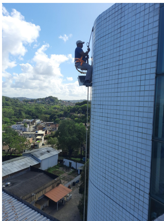
Foto 2: Serviços de reaplicação de rejunte na fachada de Biologia
