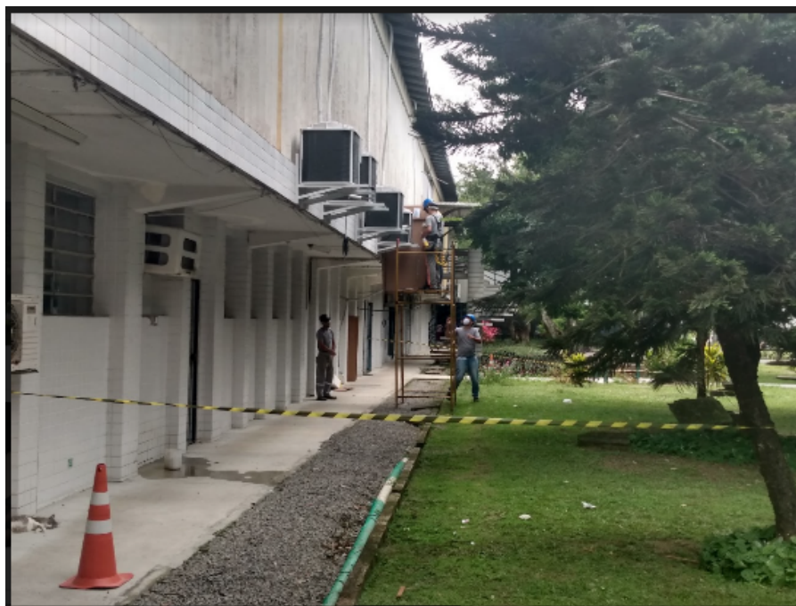
Foto 1: Instalação das condensadoras dos ar-condicionados tipo Split do Salão Nobre
