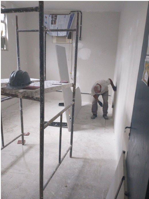
Foto 1: Paredes em fase de acabamento
