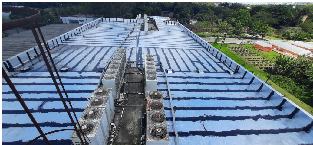
Foto 1: Aplicação de manta na cobertura do CEAGRI II
