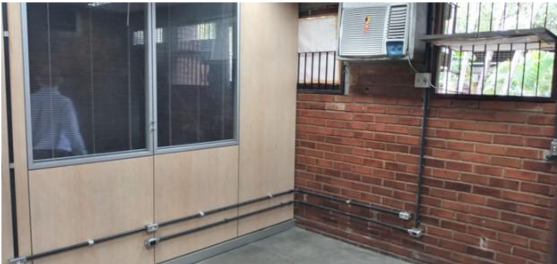
Foto 12: Instalação das tomadas de lógica concluídas na PROGEPE.
