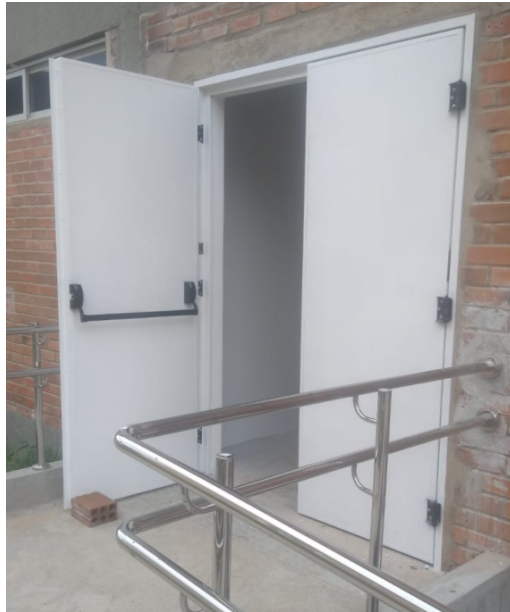
Foto 1: Saída de emergência.
