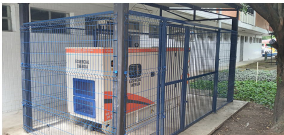
Foto 1: Instalação do gerador da Reitoria - serviços na coberta, estrutura metálica e gradil finalizados.
