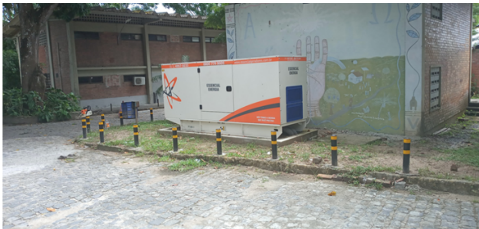
Foto 3: Finalização da instalação dos balizadores no gerador do NTI.
