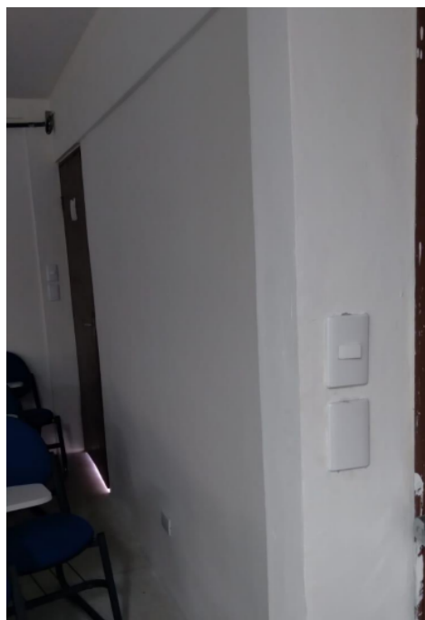
Foto 4: Fornecimento e instalação de interruptores e tampas cegas
