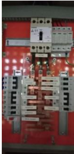
Foto 11: Instalação de disjuntores, dps no quadro do térreo, circuito independente para o rack e roteadores.
