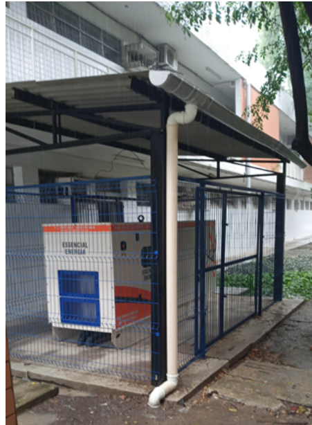
Foto 2: Instalação do gerador da Reitoria.
