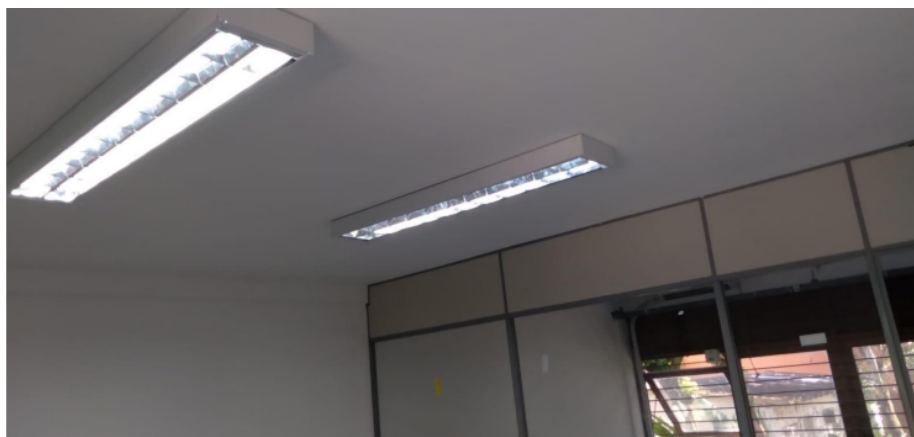
Foto 1: Fornecimento e instalação de luminárias de sobrepor com lâmpadas LED; Divisórias.
