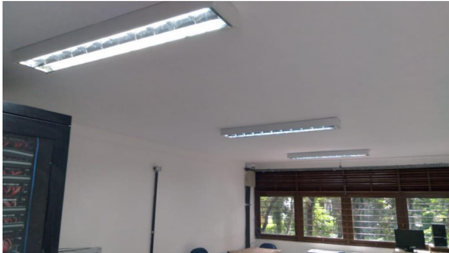
Foto 3: Fornecimento e instalação de luminárias de sobrepor com lâmpadas LED
