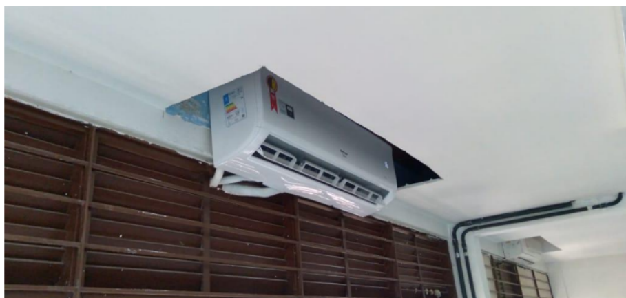
Foto 2: Fornecimento e instalação de equipamentos de ar condicionado tipo split
