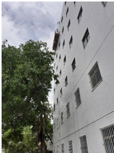
Foto 1: Fachada em execução - Biologia
