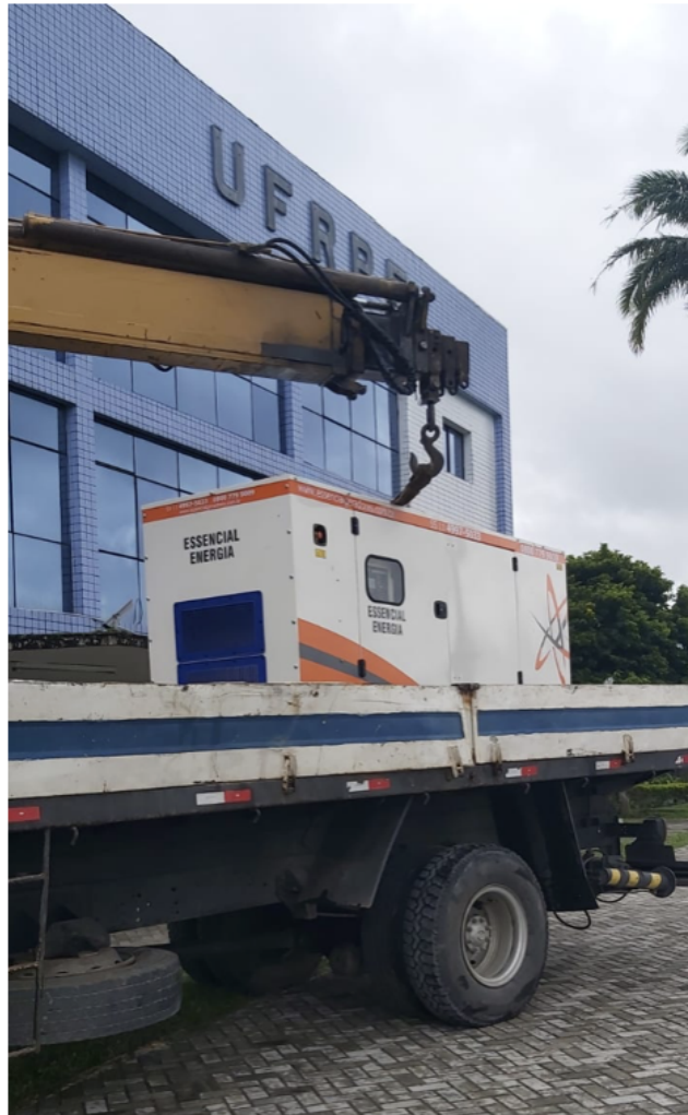
Foto 5: Colocação do gerador na base (Reitoria)
