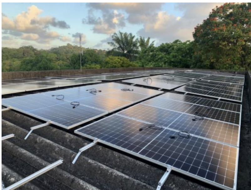
Foto 1: Placas instaladas no CEGOE
