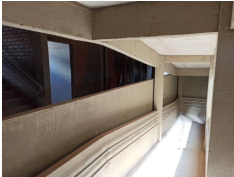
Foto 1: Rampa de acesso.
