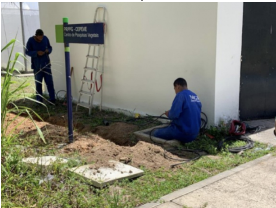
Foto 3: Finalização das obras
