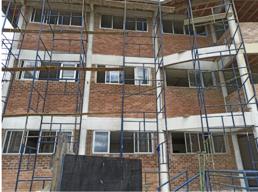
Foto 4: Pintura da fachada frontal do bloco de laboratórios
