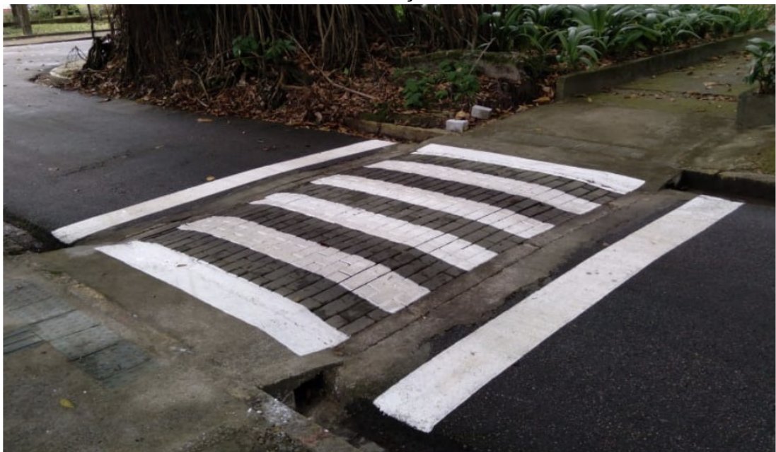
Foto 3: Demarcação dos pavimentos das passagens elevadas com pintura de sinalização.
