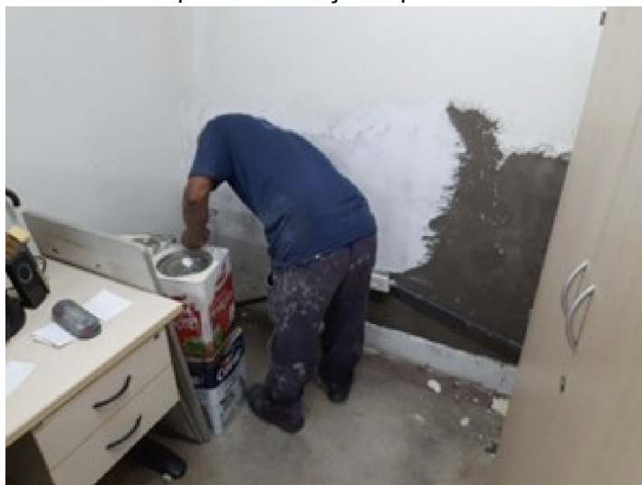
Foto 2: Impermeabilização e pintura - DEINFO
