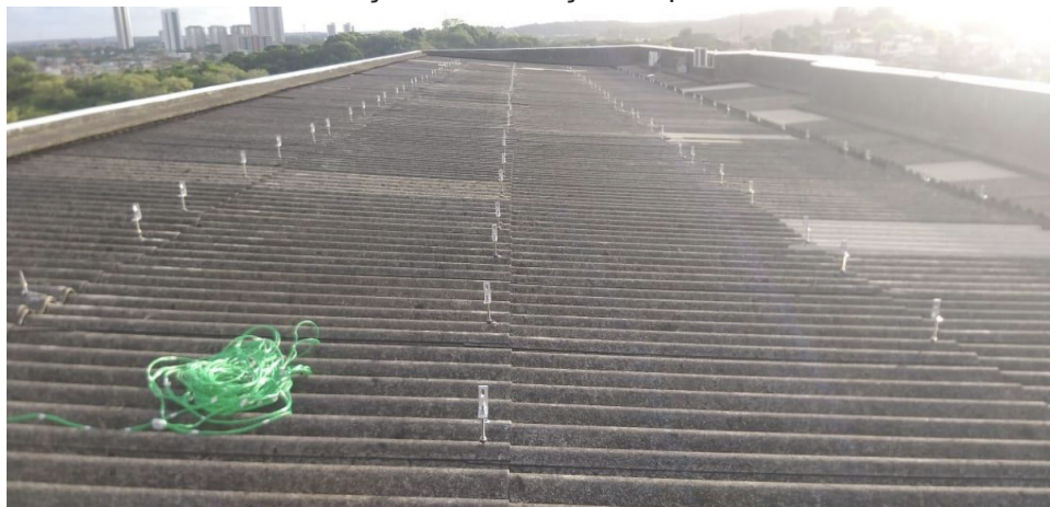
Foto 3: Início dos serviços de instalação de placas no CEGEM
