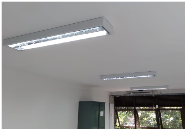
Foto 5: Instalação de luminárias e lâmpadas nas salas que compõem o 1º e 2º Pavimentos (conforme projeto).
