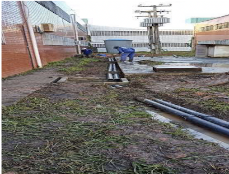
Foto 2: Preparo das instalações
