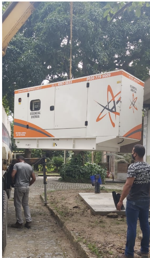
Foto 4: Colocação do gerador na base (NTI).
