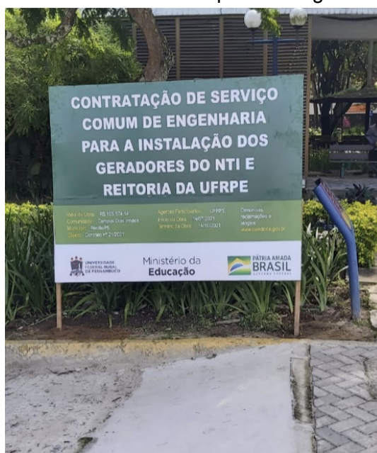
Foto 1: Placa de obra com impressão digital instalada
