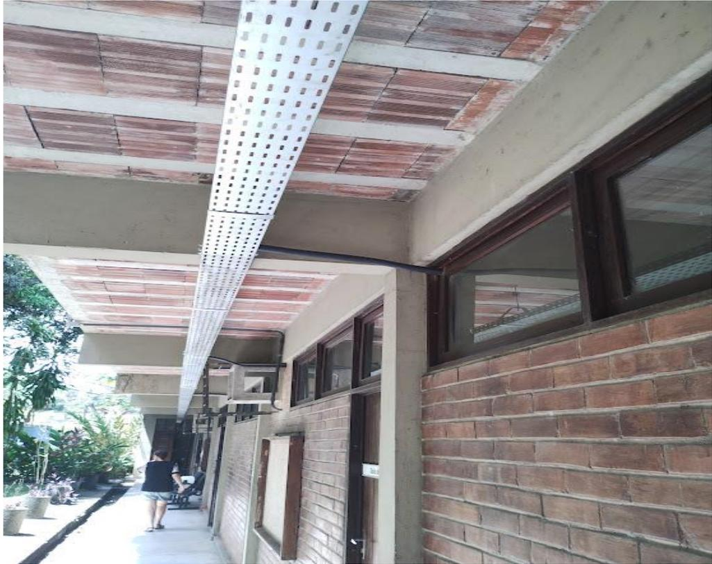
Foto 12: Instalação de Eletrocalha Corredor Prédio Ciências do Consumo.
