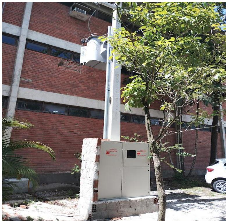
Foto 2: Instalação de Subestação Aérea de 300 kVA para a Biblioteca Central.
