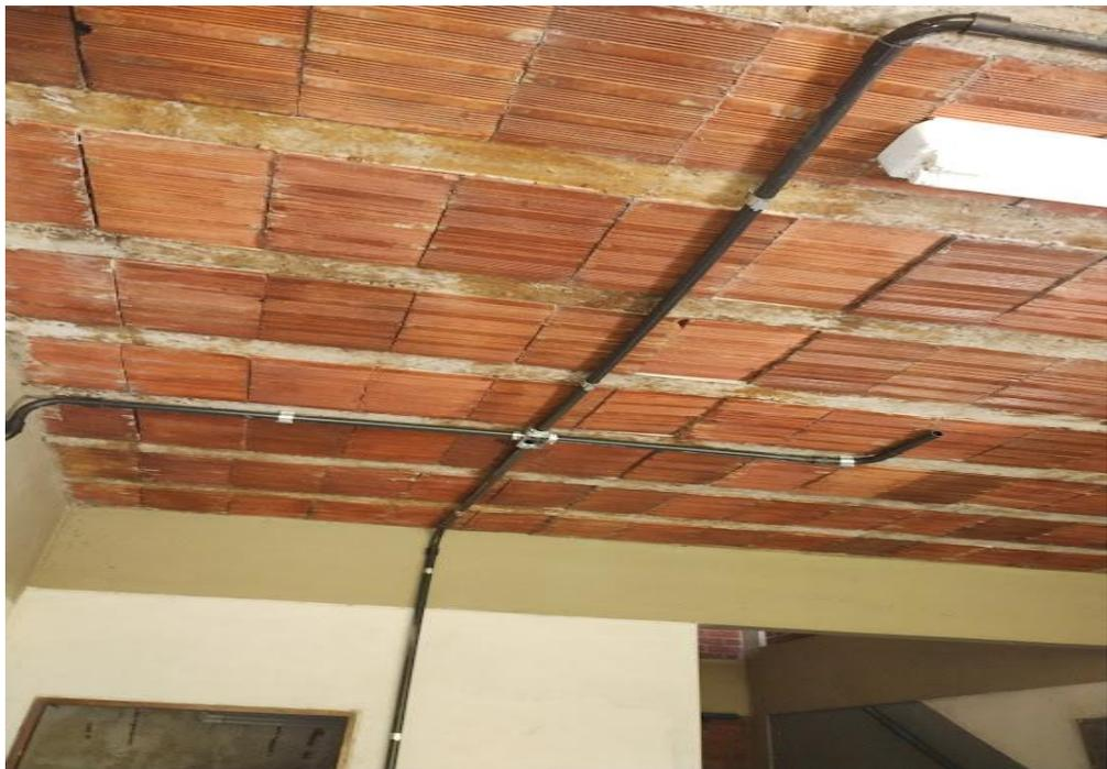
Foto 13: Instalação de condutores e eletrodutos aparentes no Prédio Ciências do Consumo.
