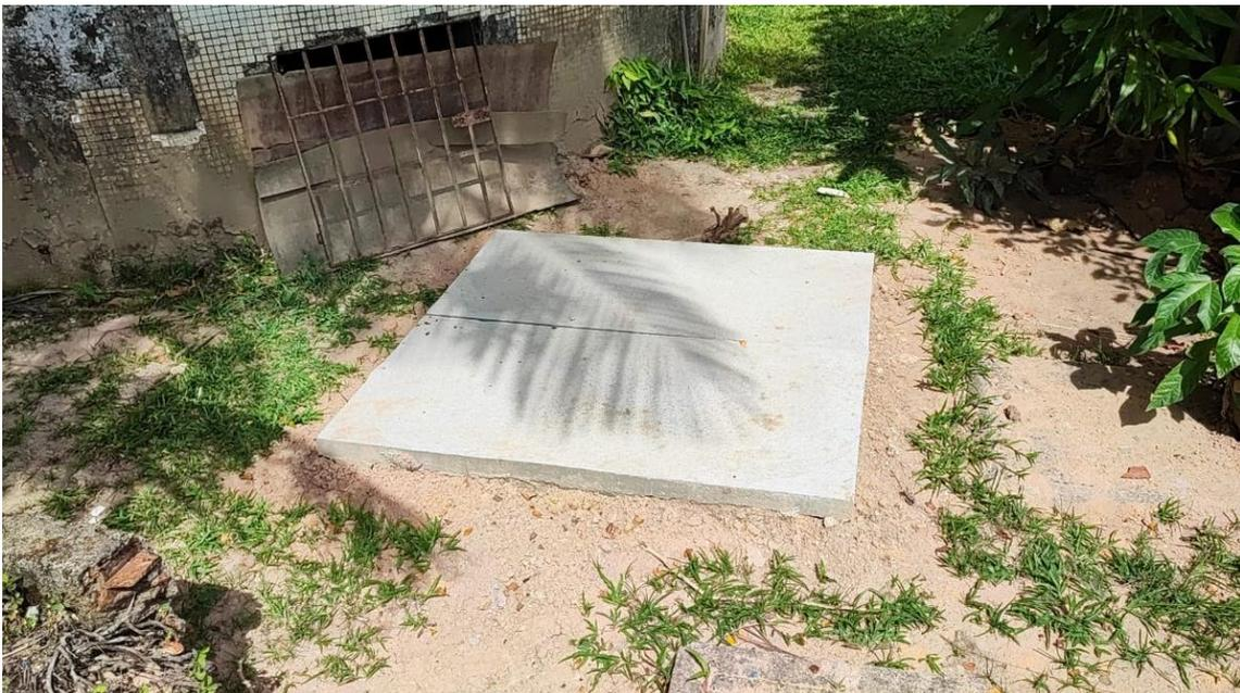
Foto 6: Finalização da caixa de passagem para os cabos de baixa tensão.
