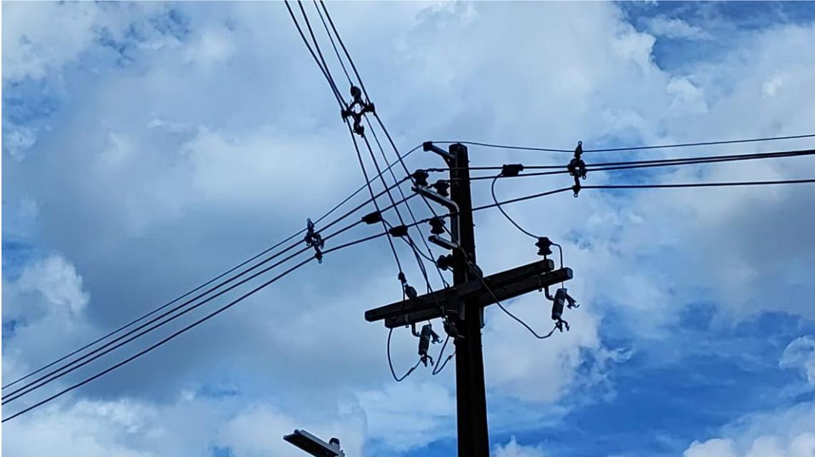
Foto 5: Derivação da rede de média tensão para a transformador novo.
